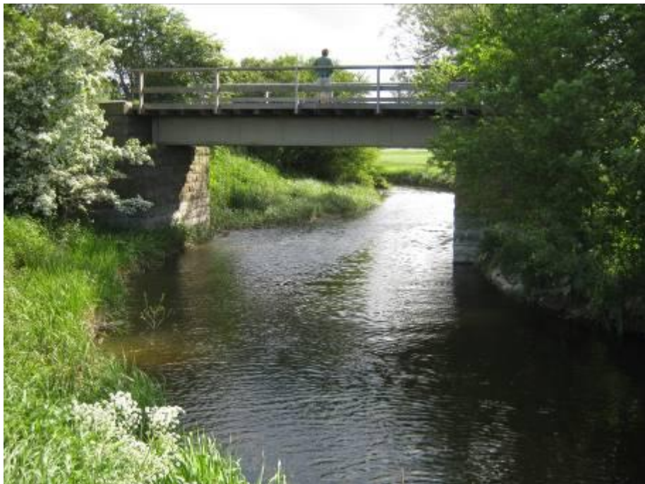
Figur 12. Halleby Å og den kraftige bro over åen. Foto CC.
