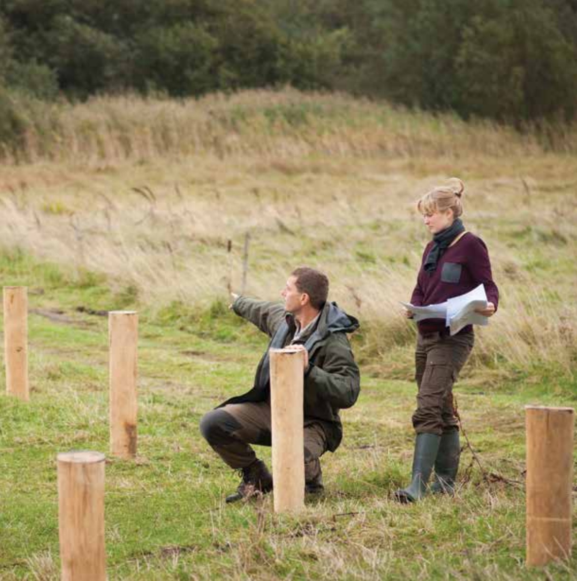
Anlæggelse af det nye fugleskjul ved Formidlingscenter Fugledegård.
